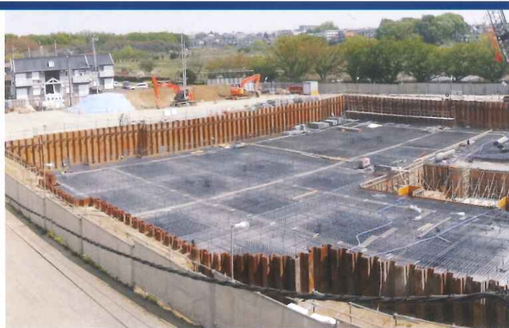
基礎躯体工事がほぼ完了しました
